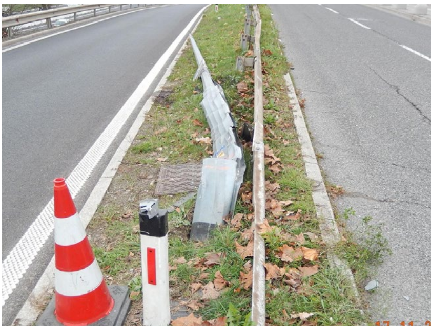
Slika 3: Pregažen pasivno siguran stup nakon udara Corse sa ocijenjenih 75 km/h. Izvor: arhiva Demeter Prislan
