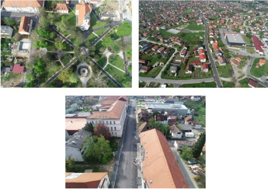
Slike 5. Prikaz izvedenih radova sanacije prometne infrastrukture Grada Petrinje
