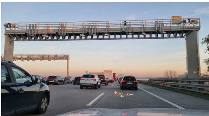
Tipični portal iznad autoceste za nadzor protoka prometa
