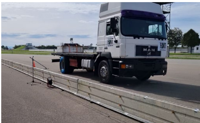
Postavljanje testa s kabelima senzorskih vlakana instaliranim na sigurnosnoj barijeri radne zone i različitim vrstama vozila
