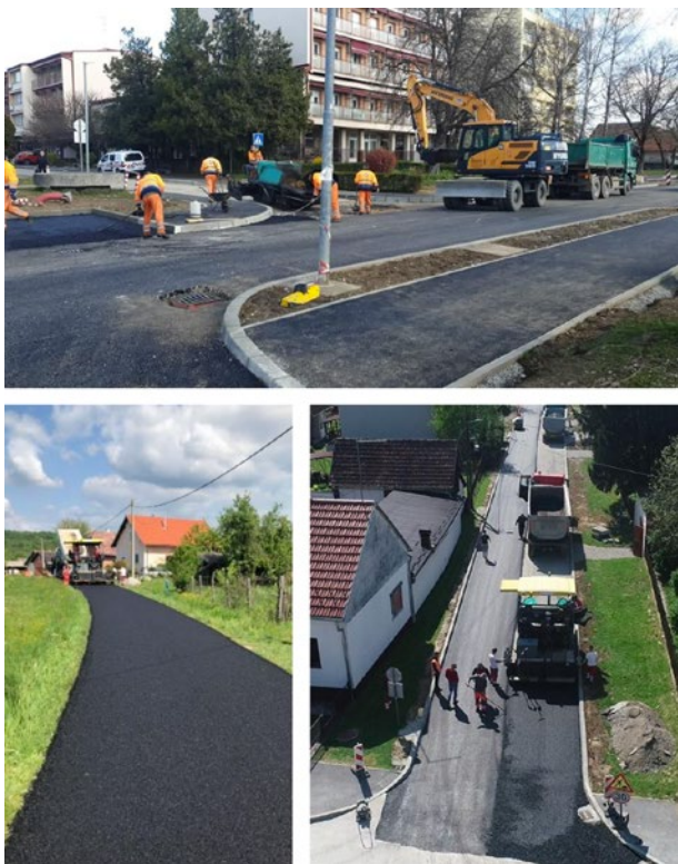
Slike 4. Prikaz tijeka izvođenja radova sanacije prometne infrastrukture Grada Petrinje
