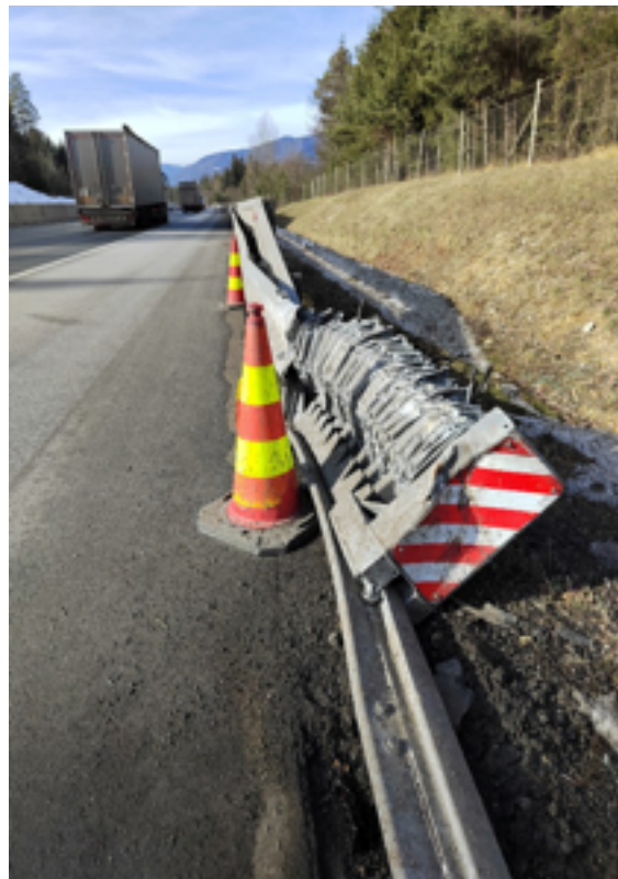
Slika 15 i 16: Početni element ispitan i na TT3.3.110 u skladu sa CEN/TS 1317-7 djeluje tako, da zadrži vozilo u svojoj blizini (exit box) – primjer iz Hrvatske (državne ceste) i iz Slovenije (autoceste). Izvor: arhiva autora
