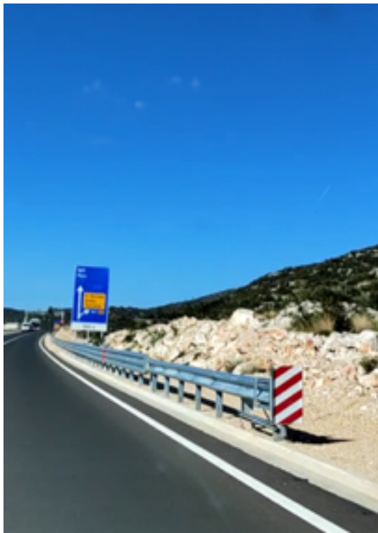
Slika 17 i 18: Početni element koji pušta vozilo u štíćenu zonu, vitoperi se i lomi, stvarajući pri tom izlomljene dijelove plašta koji mogu da prodru u kabinu vozila i tamo naprave masakr među putnicima. Izvor: arhiva autora
