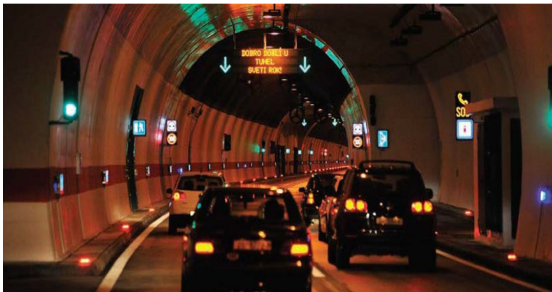
Slika 2. Tunel Mala Kapela Izvor: [3]
