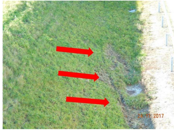
Slika 3 i 4: Pogled u suprotnom smjeru vožnje prikazuje petu kosine i tragove klizanja vozila. Izvor: arhiva autora
