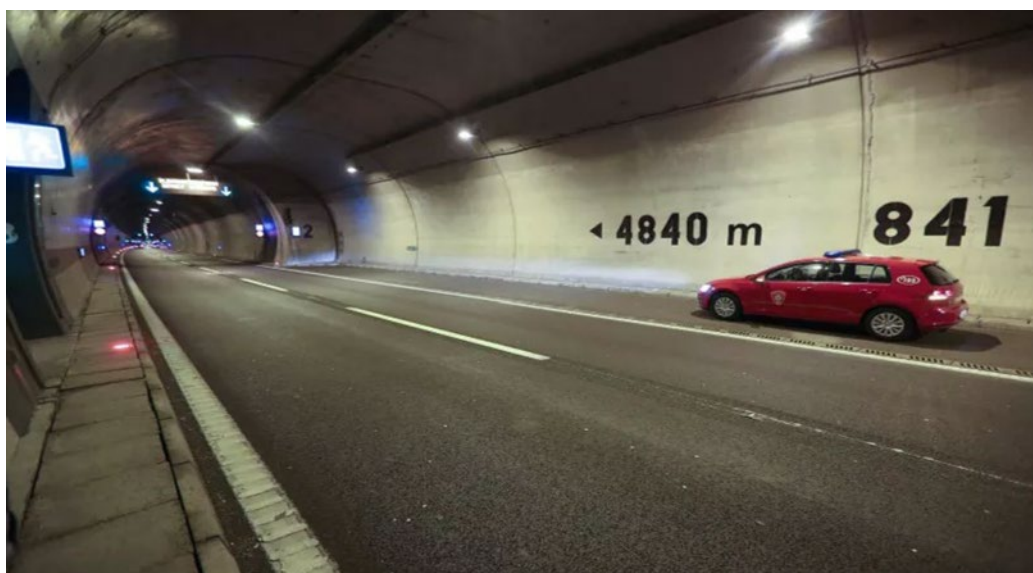
Slika 3. Prikaz ugibališta za vozila u tunelu Sveti Rok Izvor: [5]
