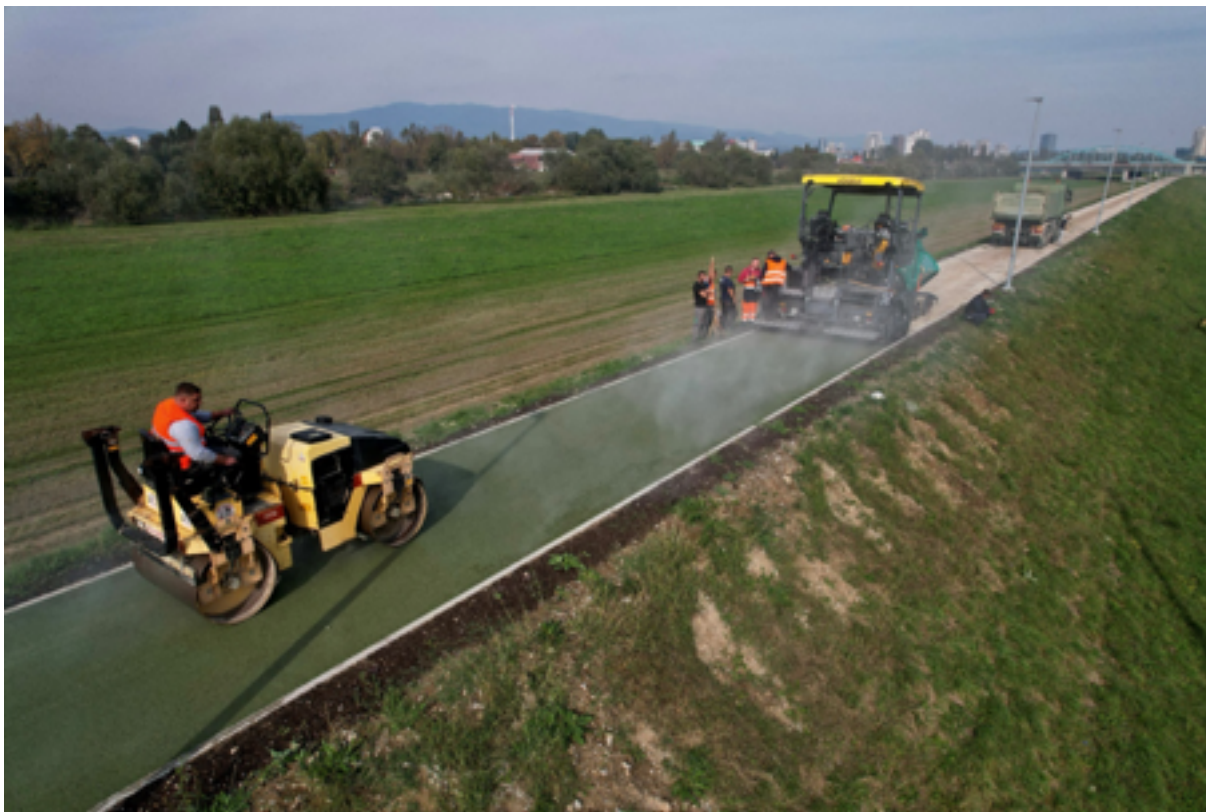
Slika 4. Asfaltiranje eko-asfaltom pilot dionice Greenway-a Izvor: Grad Zagreb, 17. listopada 2023.
