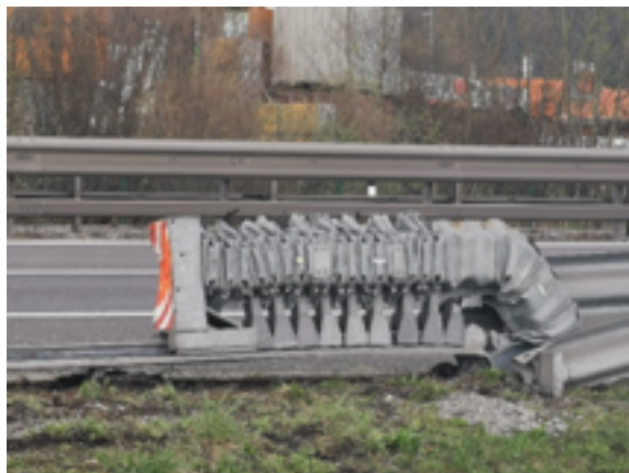
Slika 11 i 12: Maksimalno iskorišteni apsorpcijski elementi. Ukupna masa vozila u vrijeme udara cca. 1.850 kg. Brzina kretanja nepoznata. Ocjenjeni kut udara 5 - 10°. Izvor: arhiva autora i prometne policije
