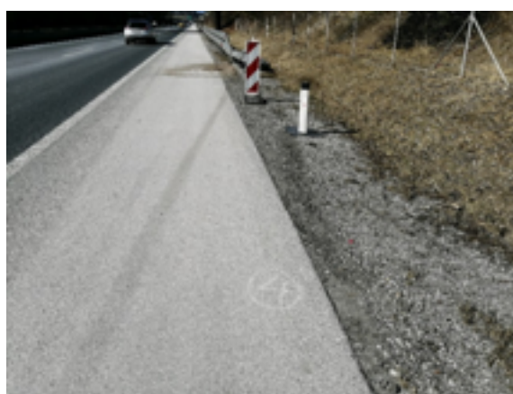
Slika 13 i 14: Vozilo je izgubilo kontrolu kretanja i skrenulo na bankinu, korekcijom vozača oporavilo se ali je zbog inercije ljuljajuće mase vozila opet skrenulo prema bankini i tamo udarilo u početni element zaštitne (odbojne) ograde. Ukupna masa vozila cca. 1.900 kg. Brzina kretanja nepoznata. Ocjenjeni kut udara 7°. Izvor: arhiva autora i službe za održavanje
