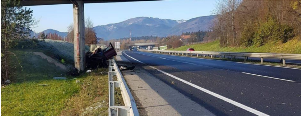
Slika 5: Tragična posljedica katapultiranja vozila na kosom početnom elementu Izvor: arhiva autora - web stranica www.dnevnik.si
