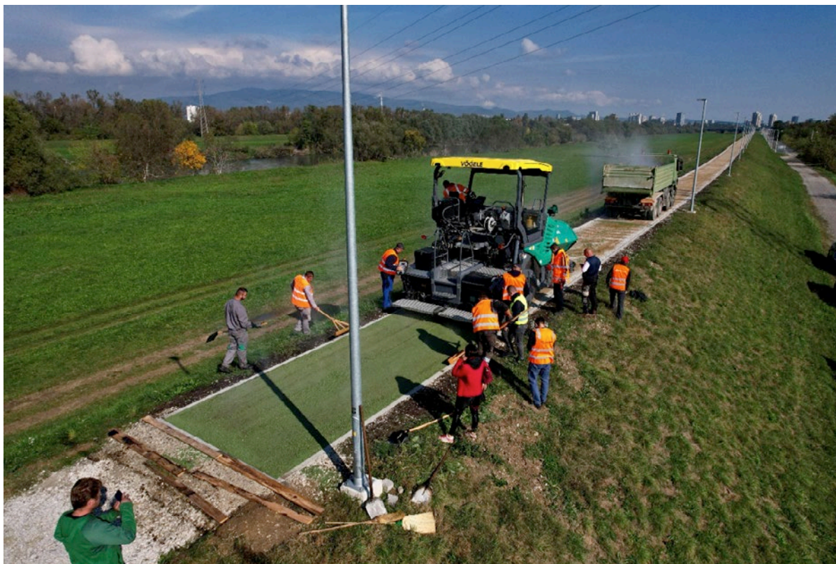
Sl.1. Početak asfaltiranja eko-asfaltom 17. listopada 2023. Izvor: Grad Zagreb, 2023.
