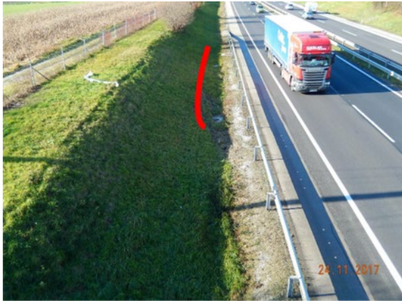
Slika 3 i 4: Pogled u suprotnom smjeru vožnje prikazuje petu kosine i tragove klizanja vozila. Izvor: arhiva autora
