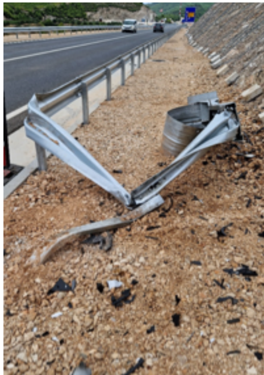
Slika 17 i 18: Početni element koji pušta vozilo u štíćenu zonu, vitoperi se i lomi, stvarajući pri tom izlomljene dijelove plašta koji mogu da prodru u kabinu vozila i tamo naprave masakr među putnicima. Izvor: arhiva autora
