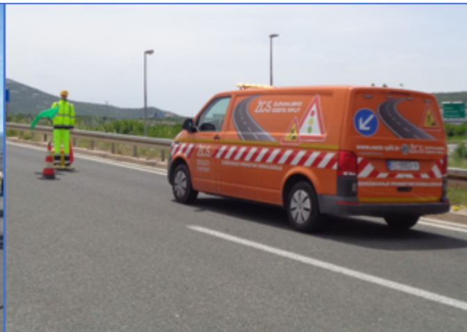
Slika 11.. Korištenje elektromehaničke lutke kod privremenih regulacija prometa (izvor:ŽCS)
