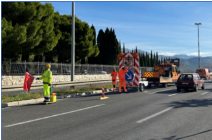
Slika 10.. Korištenje elektromehaničke lutke kod privremenih regulacija prometa (izvor:ŽCS)
