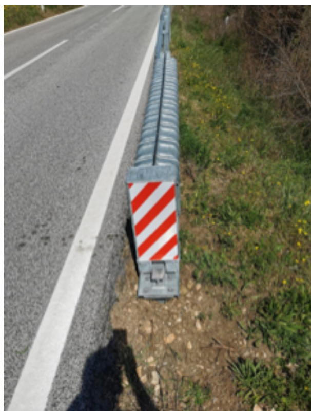
Slika 15 i 16: Početni element ispitan i na TT3.3.110 u skladu sa CEN/TS 1317-7 djeluje tako, da zadrži vozilo u svojoj blizini (exit box) – primjer iz Hrvatske (državne ceste) i iz Slovenije (autoceste). Izvor: arhiva autora
