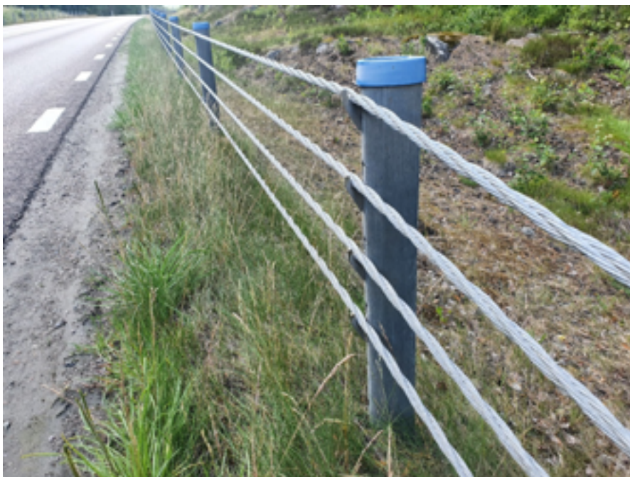
Slika 2. Zaštitna ograda s čeličnim pletenicama (Da li ova ograda stvarno oprašta pogrešku motociklista?).
