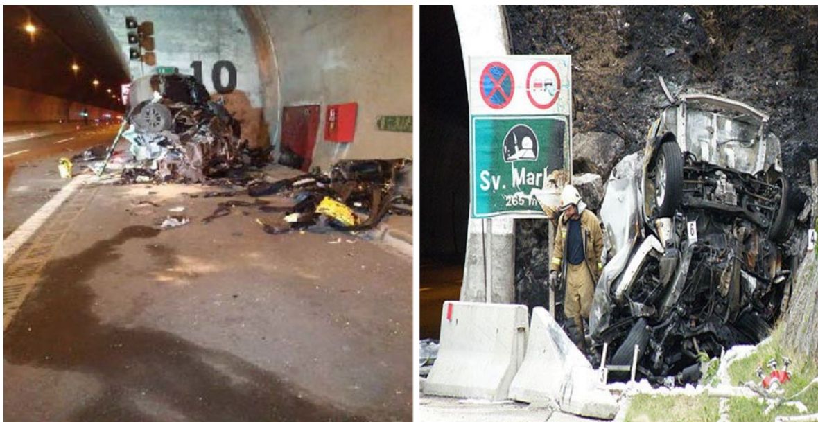
Slika 5. Nalet vozila na betonski zid u tunelima Sveti Rok i Sveti Marko Izvor: [5]
