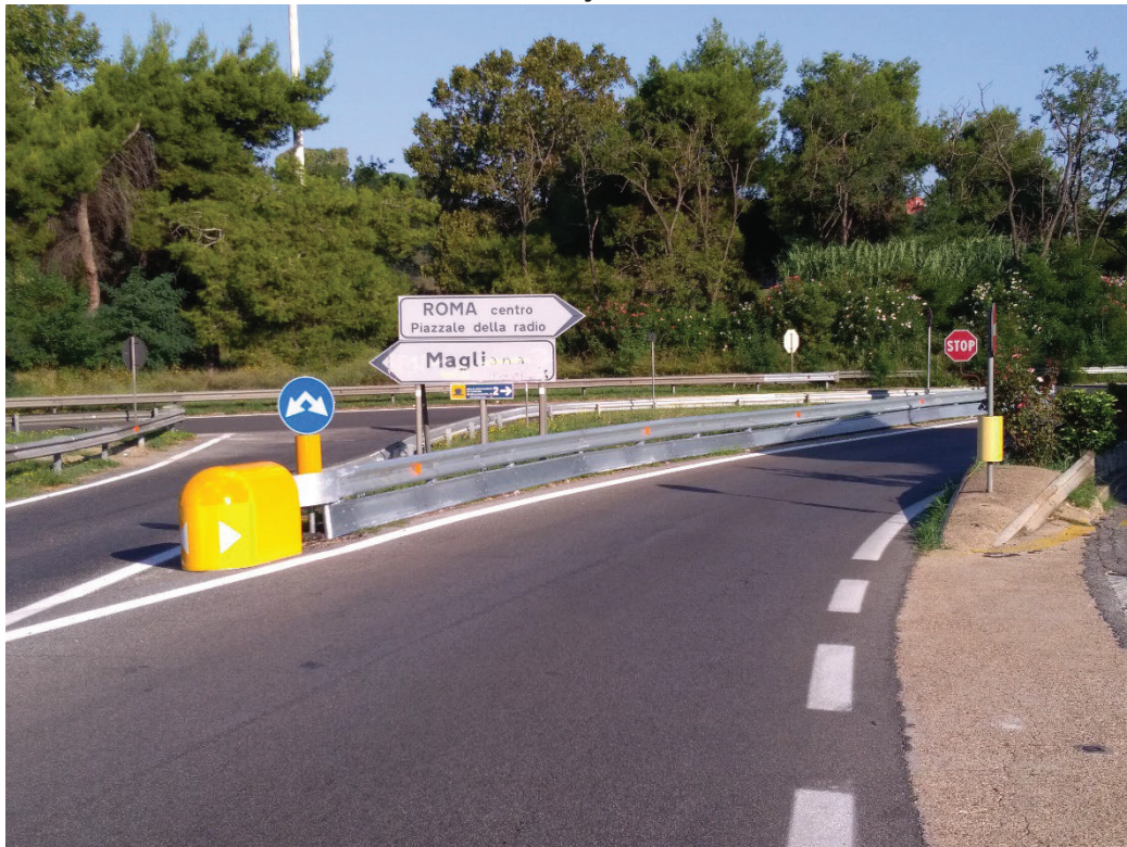
Slika 7. Ublaživač ARMADILLO, smišljen za motoriste.
