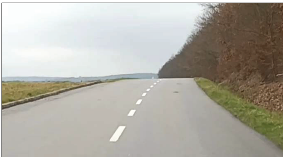
Slika 9. Projektirana i izvedena isprekidana razdjelna crta (konveksni ili vertikalni zavoj) Prijedlog iscrtati punu razdjelnu crtu umjesto isprekidane
