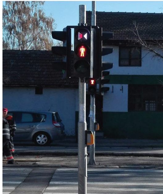
Slika 4 Uređaj koji pokazuje vrijeme dok se ne pojavi zeleno svjetlo za pješake
