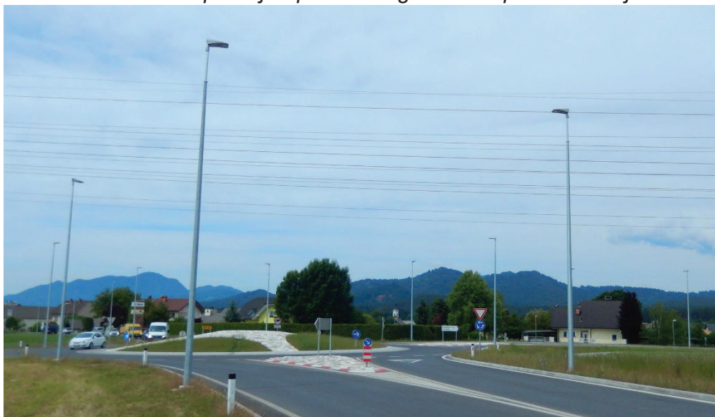
Slika 3. Kružni tok opremljen pasivno sigurnim stupovima rasvjete.
