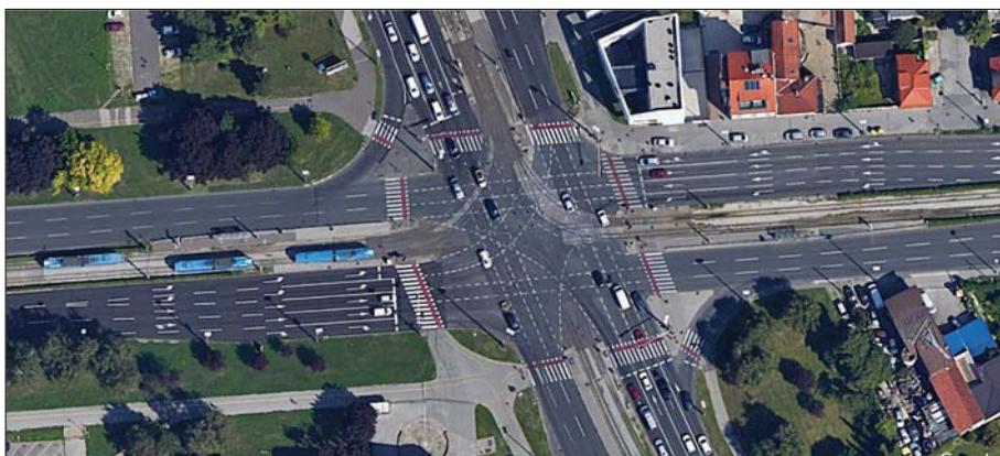
Slika 10. izvedena crta vodilja (Zagreb; raskrižje ulica Grada Vukovara i Marina Držića)
