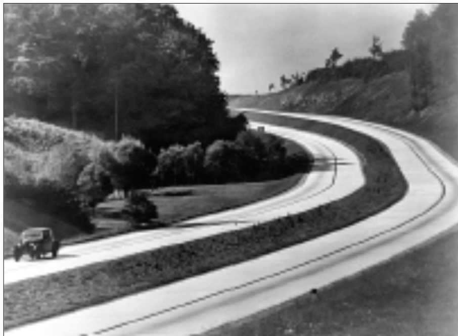
Slika 2. „ Crne oznake ” koje su izvedene na njemačkoj autocesti.
