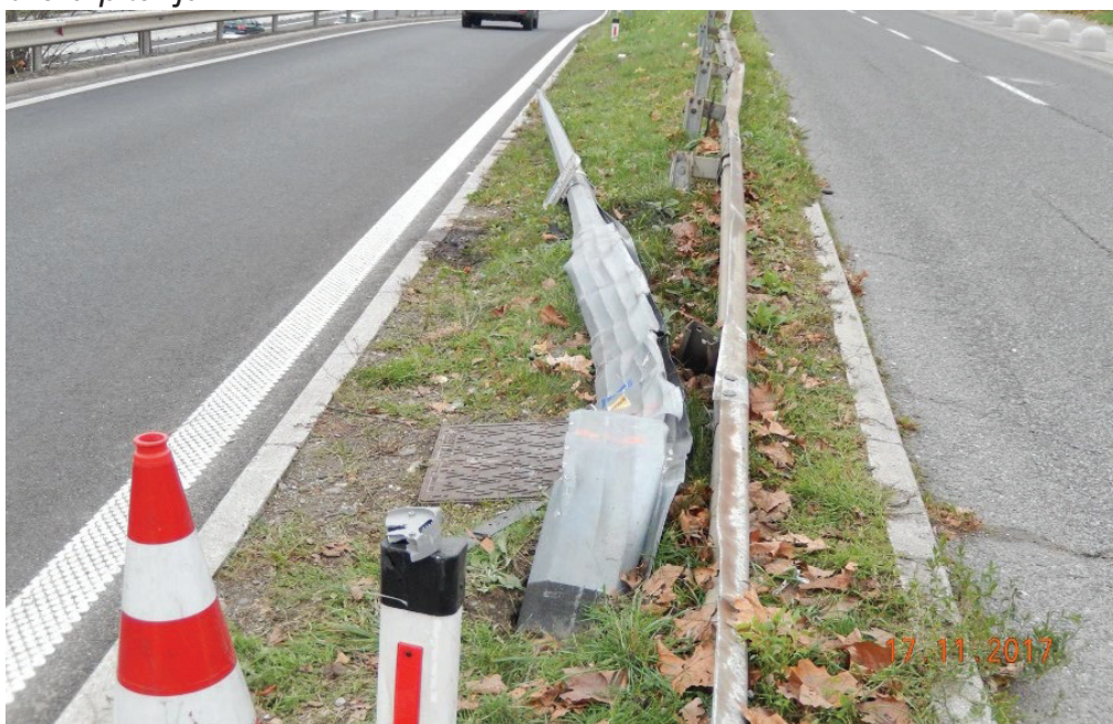
Slika 4. Oboren pasivno siguran ZIP stup je spasio život, samo je materijalna šteta bila u pitanju.
