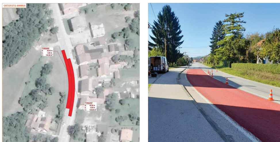
Slika 6: Protuklizna podloga u Ulici Mostanje u Karlovcu
