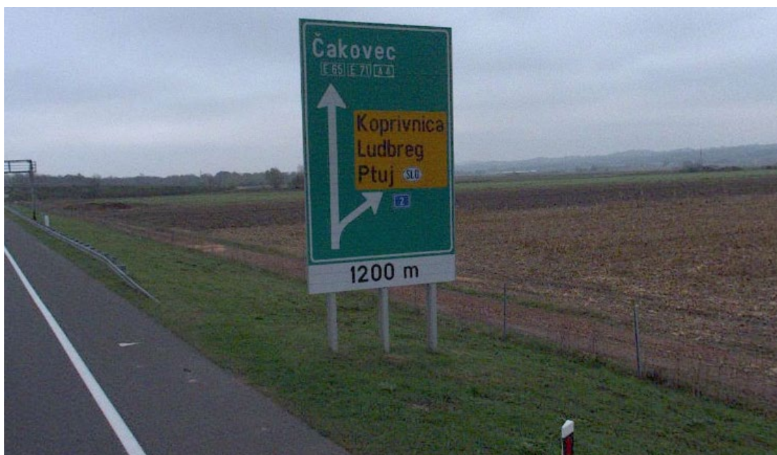
Slika 9. Putokazne ploče na NPI nosačima
