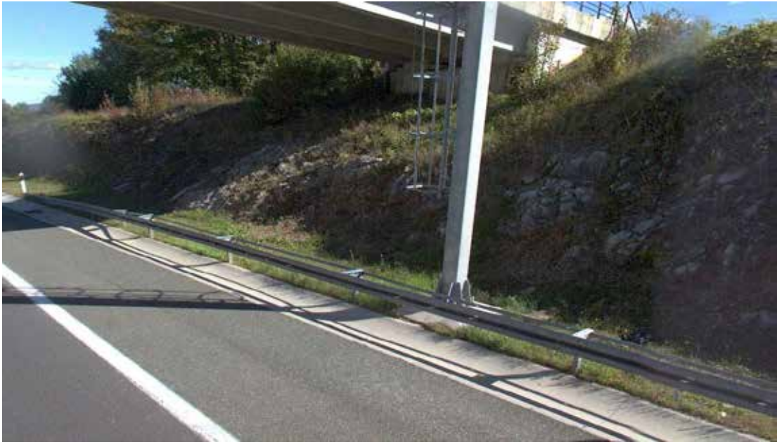
Slika 2. Stup portala uz rub kolnika
