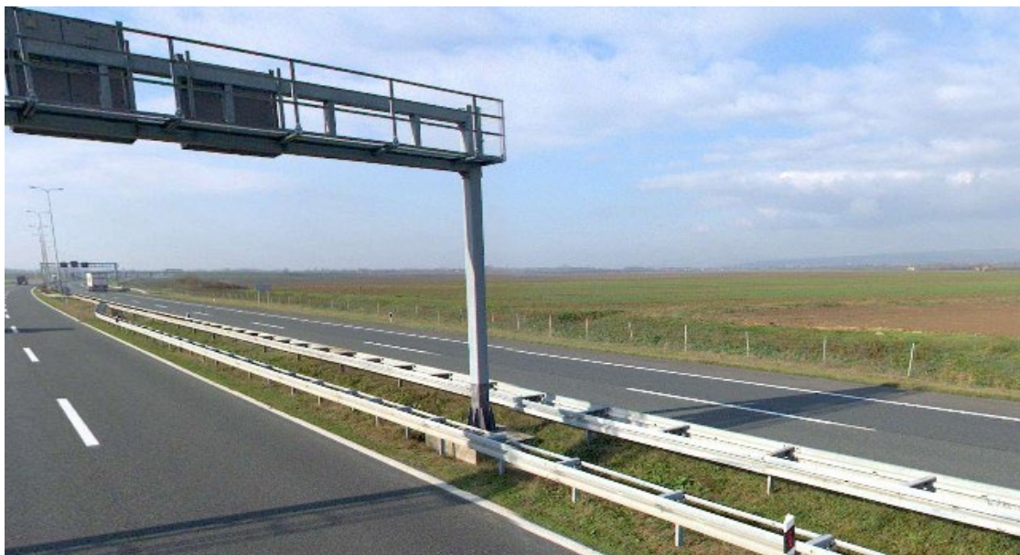
Slika 7. Odbojna ograda uz stupove portala radjelnog pojasa
