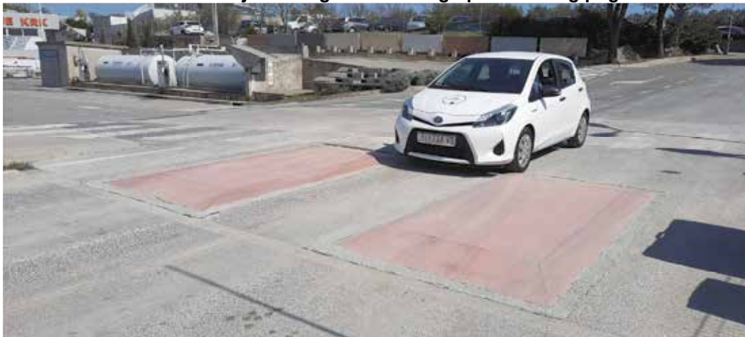
Slika 4: Armiranobetonski jastuci ugrađeni u krugu proizvodnog pogona GP Krka-a
