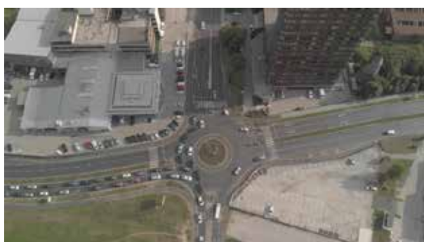
Slika 14. Postojeće stanje kružnog toka Energoinvest
