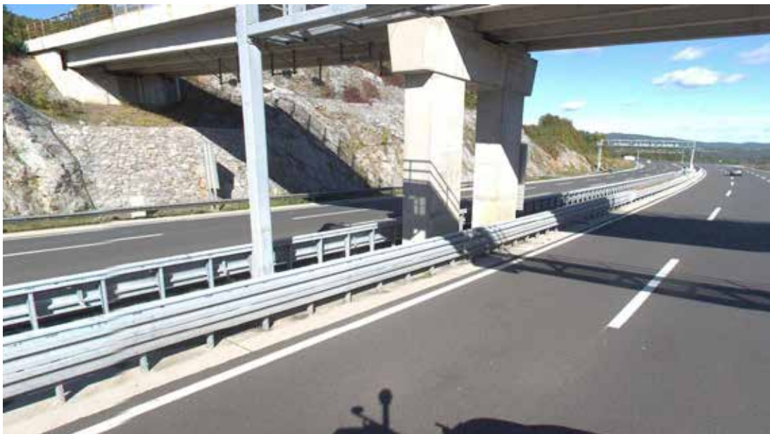
Slika 3. Stup portala i betonski stupovi u razdjelnom pojasu
