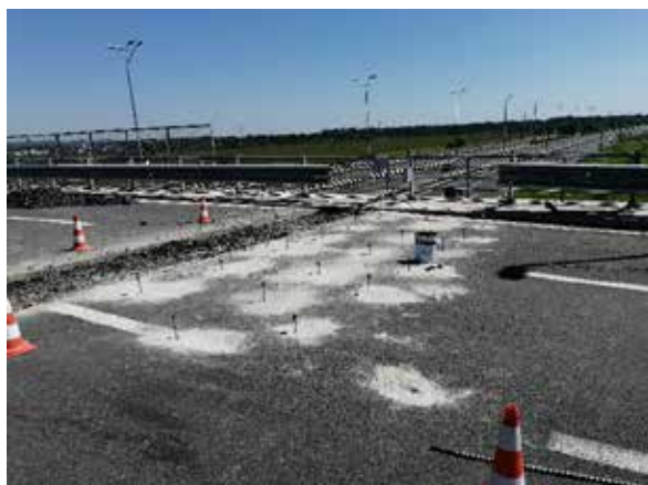
a) Postavljene cjevčice za duboko injektiranje b) Pristupna cesta – predmet sanacije
