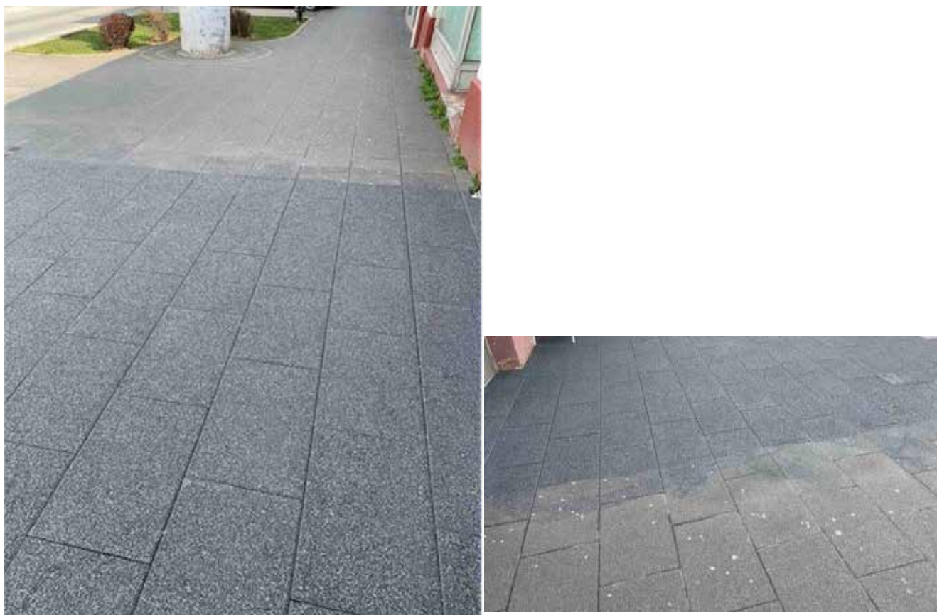
Slika 11. Pastella ploča 60/30/3,8 antracit ugrađena u Đakovu 2009. godine, čišćenje provedeno 2020. godine
