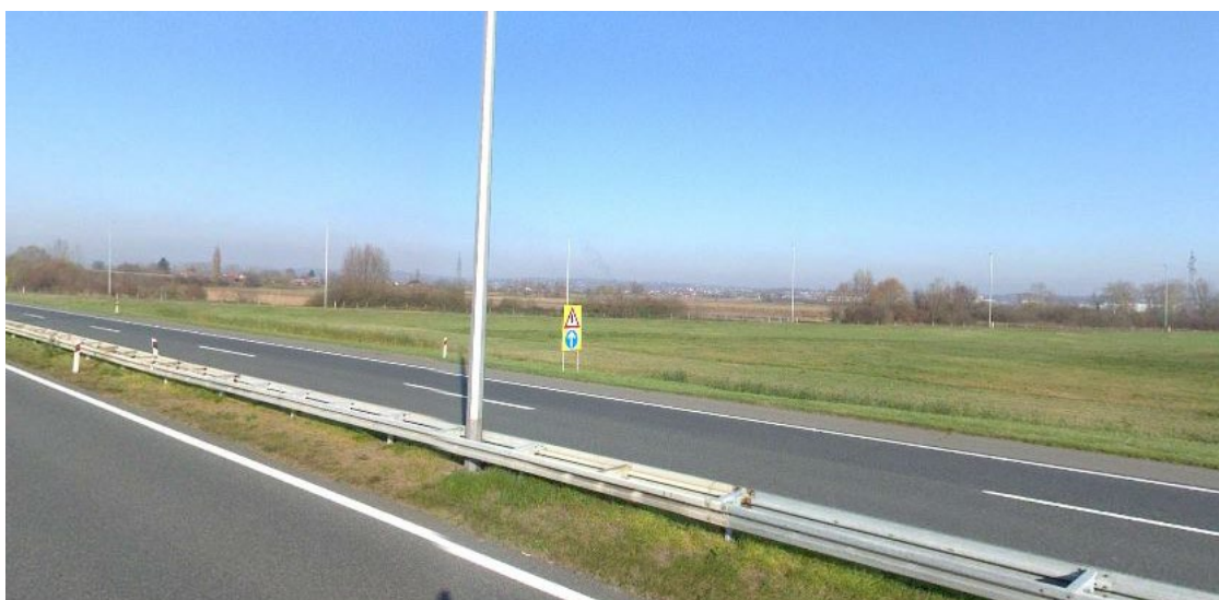
Slika 8. Dvostrana distantna ograda i stup rasvjete u razdjelnom pojasu
