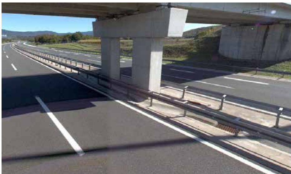
Slika 4. Dvostruka distantna odbojna ograda uz upornjak razdjelnog pojasa
