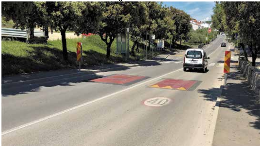
Slika 15: AB-Jastuci ugrađeni u Ulici Slavka Nikolića
