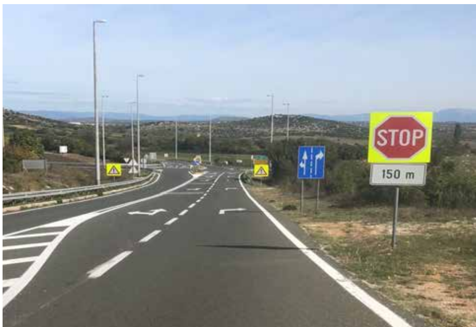
Slika 7 Prikaz poduzetih mjera do potpune sanacije opasnog mjesta „Raskrižje DC27 – DC59“ u Stankovcima
