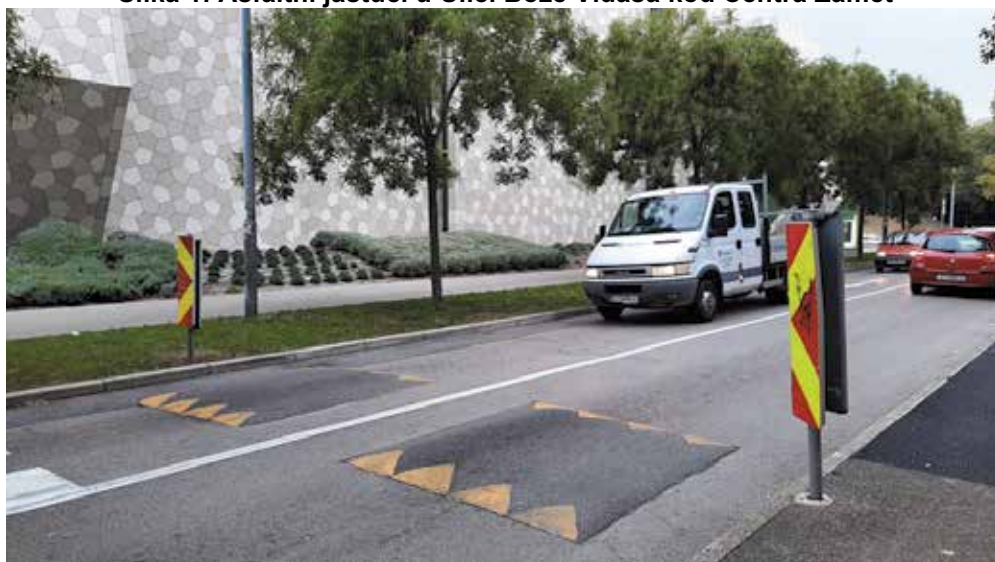
Slika 1: Asfaltni jastuci u Ulici Bože Vidasa kod Centra Zamet
