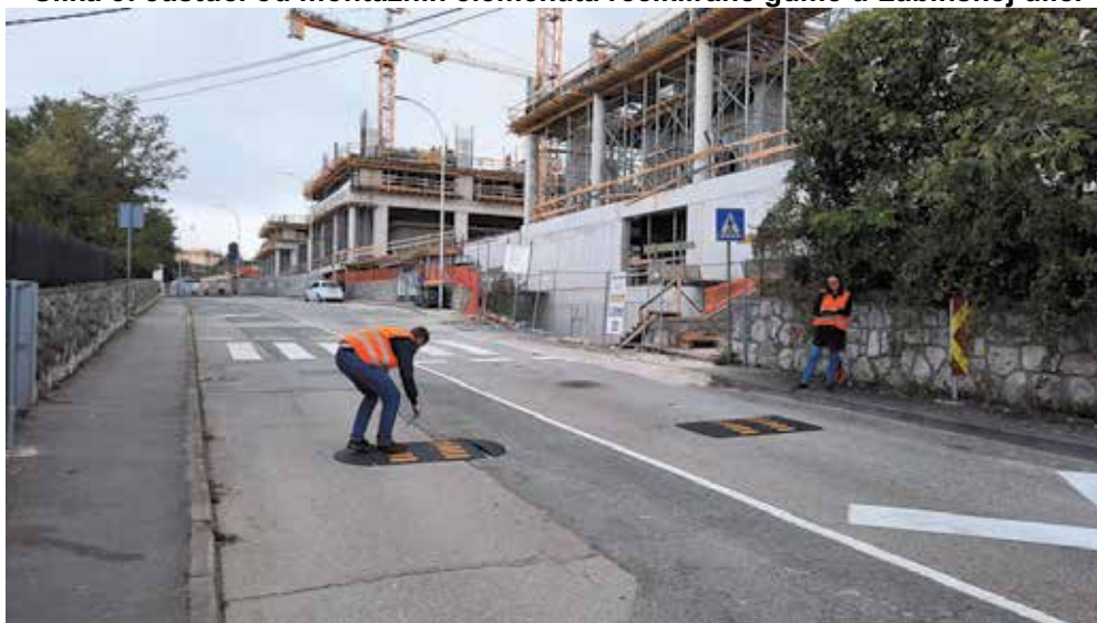
Slika 3: Jastuci od montažnih elemenata reciklirane gume u Labinskoj ulici
