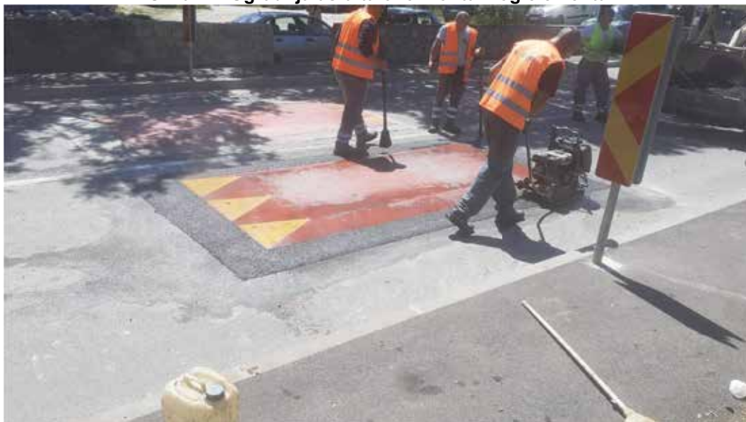
Slika 14: Ugradnja asfalta oko montažnog elementa
