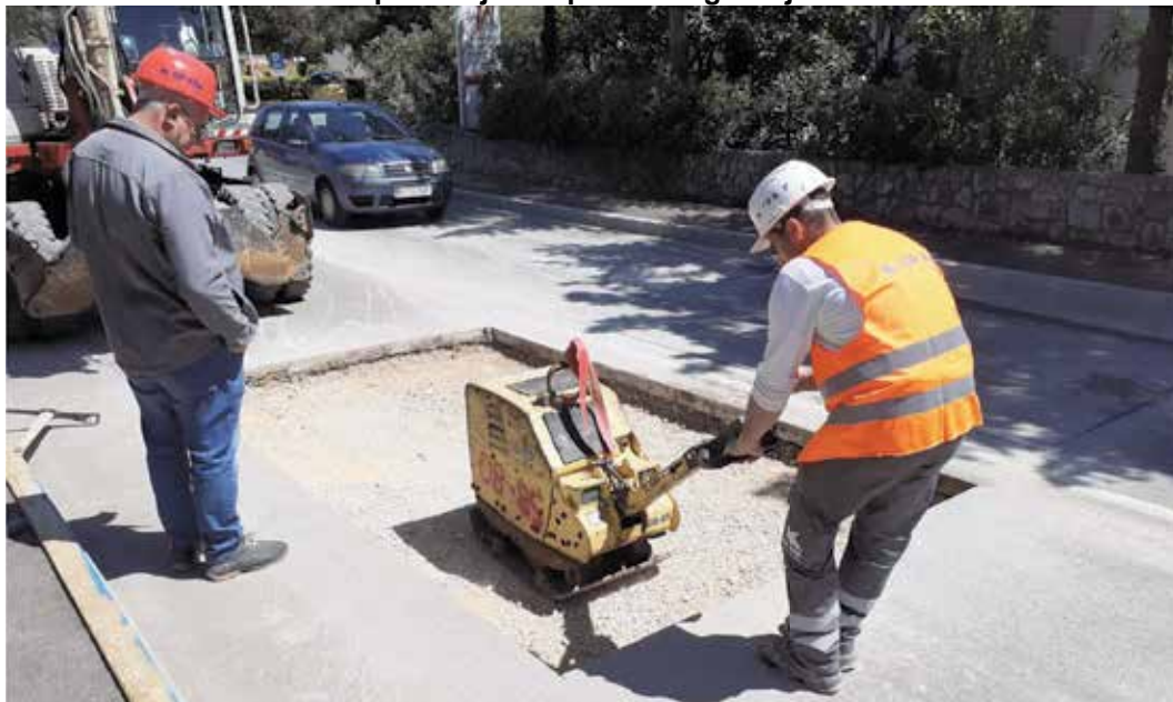
Slika 12: Pripremanje tampona za ugradnju AB-Jastuka
