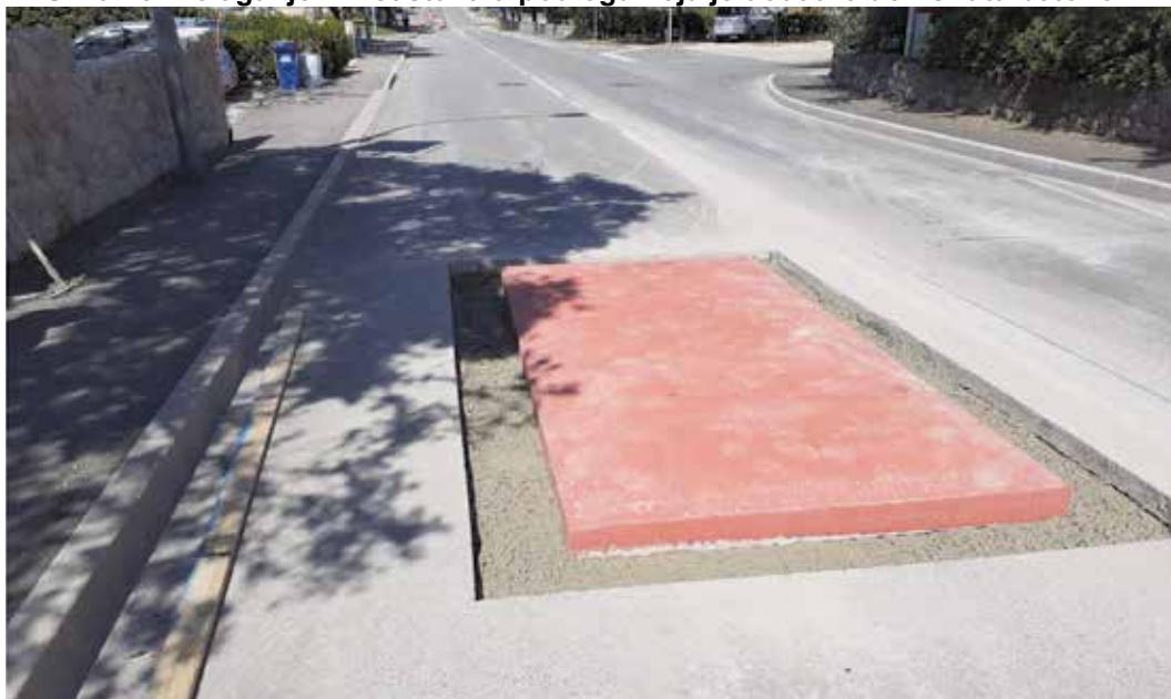
Slika 13: Polaganje AB-Jastuka u podlogu koja je dodatno učvrsnuta betonom
