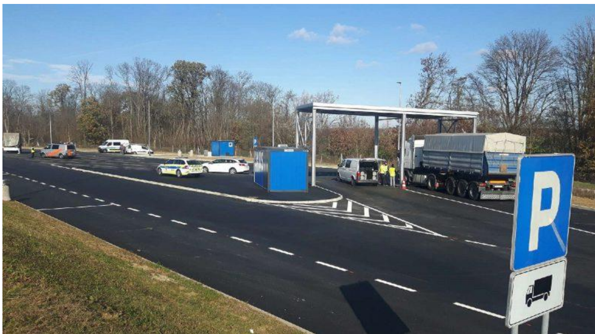
Slika 3. Objekti i oprema na nadzornoj točki
