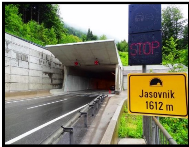
Slika 8. Portal tunela Jasovnik
