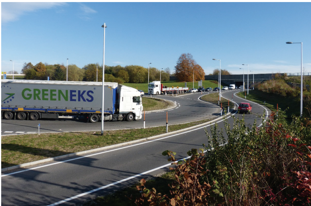
Slika 1. Tangencijalna (smičuća) opterećenja koja djeluju na kolovoz kružne raskrsnice Izvor: Hrapović K. 06.11.2015
