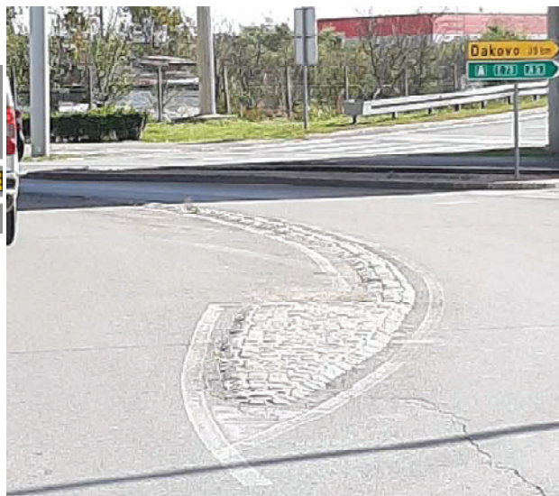
Slika VIII. Izvedena kaplje od granitne kocke
